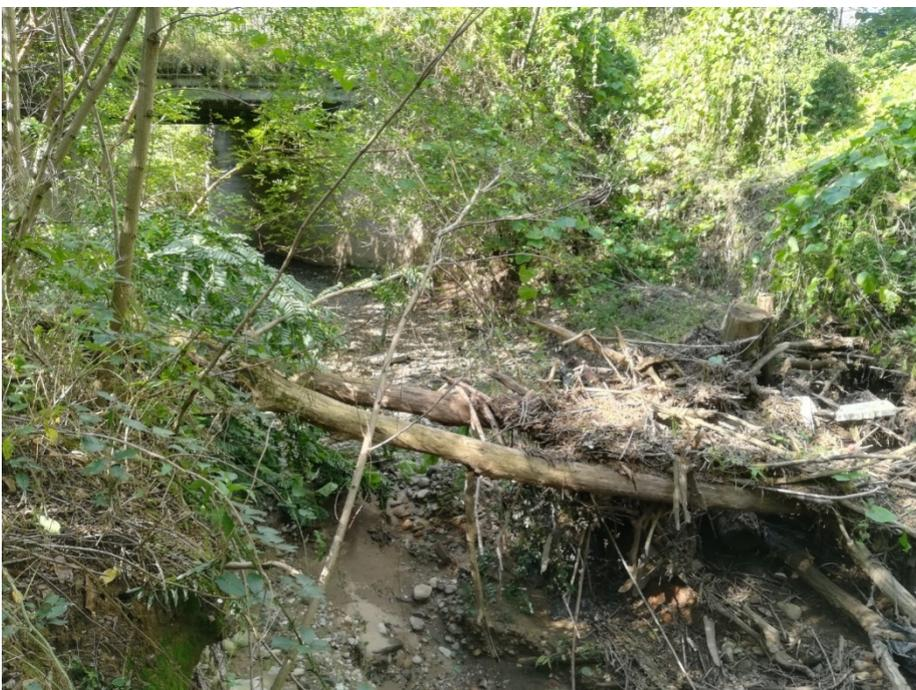
Figura 1: vegetazione d'alto fusto occlude la sezione di flusso di un ponte.
