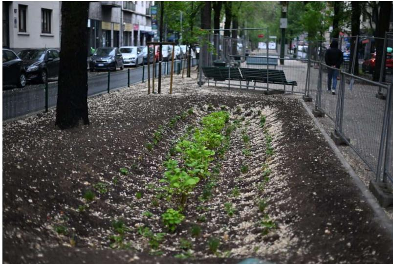
Figura 44 - Drenaggio urbano disposto in via Pacini a Milano per consentire un maggiore afflusso di acqua di pioggia alle radici e per evitare la sua dispersione e contaminazione sull'asfalto
