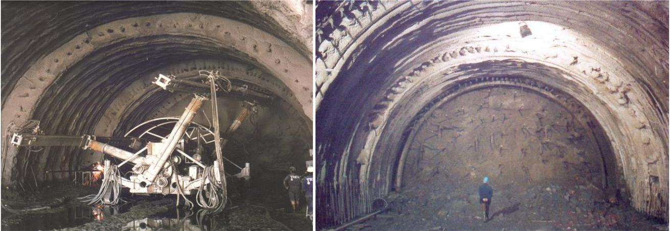
Qualora la realizzazione dell'opera sia preceduta dallo scavo di un foro pilota, si ricorre frequentemente a interventi di consolidamento radiale da cunicolo, generalmente mediante tubi in vetroresina eventualmente valvolati e iniettati, le cui parti contenute entro la sagoma della futura galleria sono facilmente removibili in sede di allargo.
