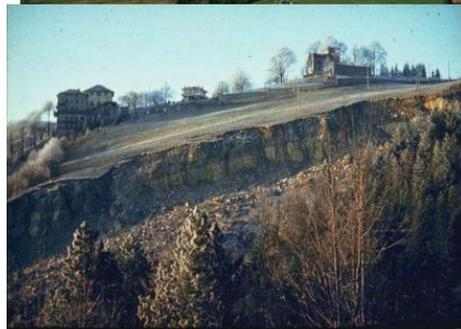
Nelle figure esempi di scivolamento planare. La figura a sinistra mostra tutti i sintomi precursori del collasso del versante per scivolamento. Nelle due foto: a) in alto i sintomi di movimento nei livelli superiori del terreno (smottamenti e frane secondarie), b) in basso si riconoscono le fratture verticali parallele al pendio che interessano l'ammasso roccioso in frana e il proseguimento sul versante sotto forma di fessure nel terreno e rigonfiamenti
