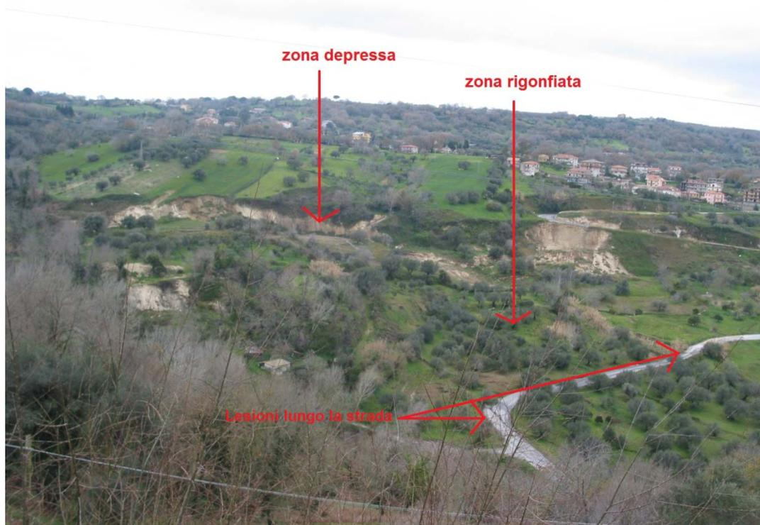
**Figura 8 - Evidenze deformative lungo il versante successivamente collassato. Si osserva la presenza di una zona depressa a monte e una rigonfiata a valle (in corrispondenza della strada, per altro lesionata).**
