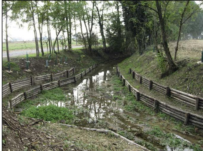
Figura 7: un fontanile e le opere di difesa dall'interramento che si verificherebbe senza le protezioni dalle frane spondali
