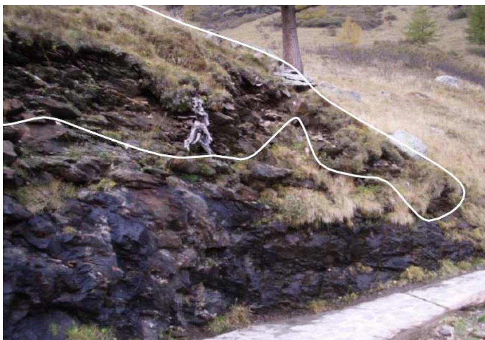
Figura 1 – Esempio di versante con evidenti segni di instabilità
